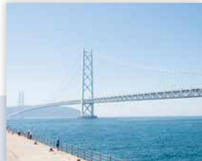
明石海峡大橋
